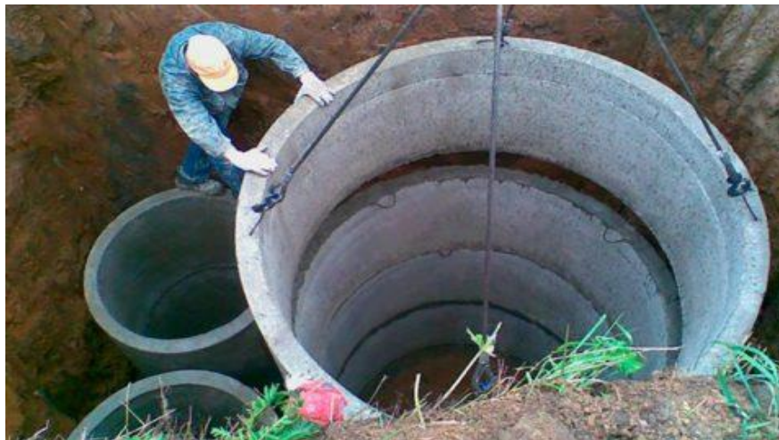
А.1.4.3 – сурет Сантехникалық фитингтерді орнату үшін темірбетон ұңғымаларын орнату
